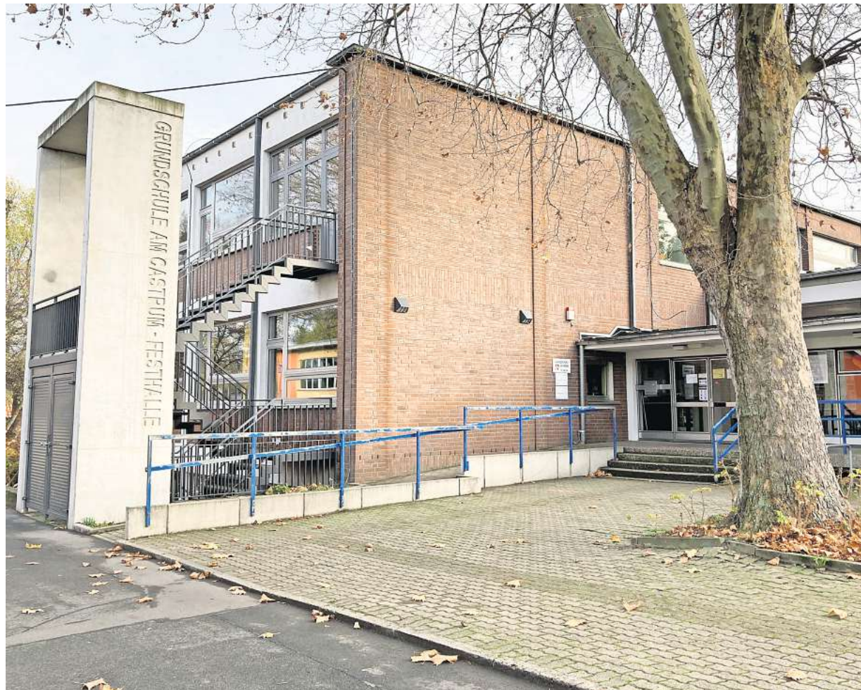
Die Tage sind gezählt: Die Grundschule Am Castrum wird abgerissen. Dafür entsteht an gleicher Stelle für fast 34 Millionen Euro ein Neubau
