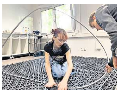
Auf die Plätze fertig los: Freya gibt ordentlich Gas beim Verlegen der Fußbodenheizung und ihr Mitschüler Jason hilft.
